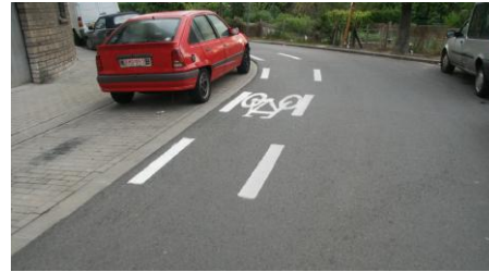
Додаткова розмітка для попередження автомобілістів про велосипедну контр-смугу за поворотом, Брюссель, Бельгія (D. Dufour)
